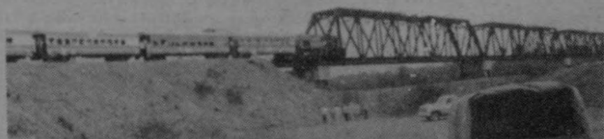
Puente Ferroviario sobre el Río Frío, el más grande en Centroamérica.
