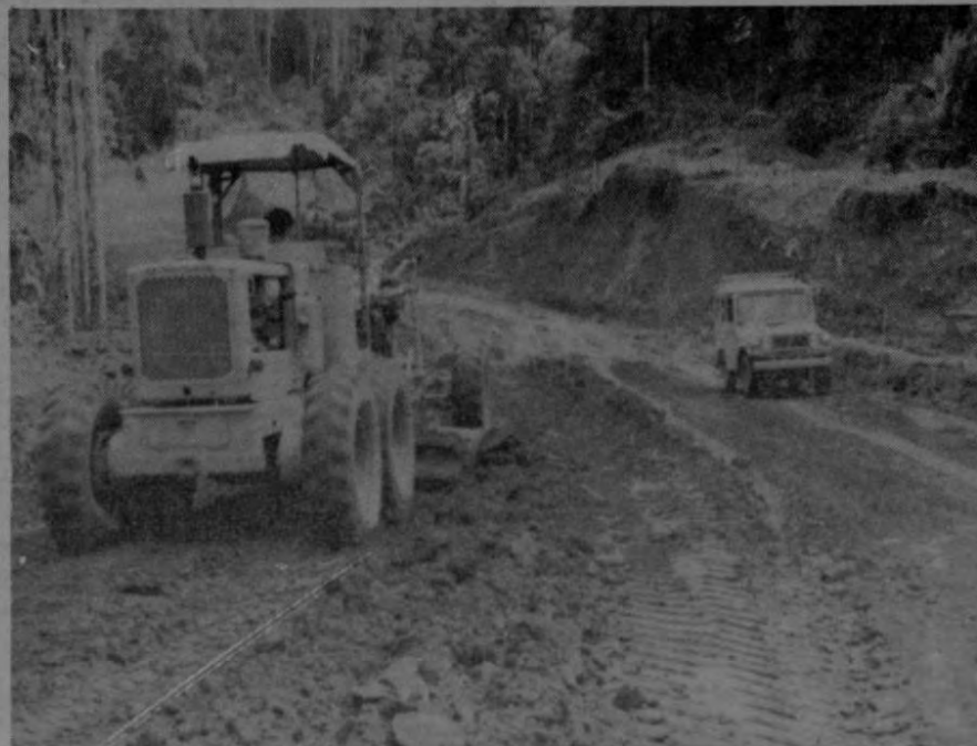
Hasta las zonas alejadas del país ha llegado la vasta construcción de caminos y carreteras. Aquí maquinaria del MOPT rompe montaña en Rincón de Osa.
